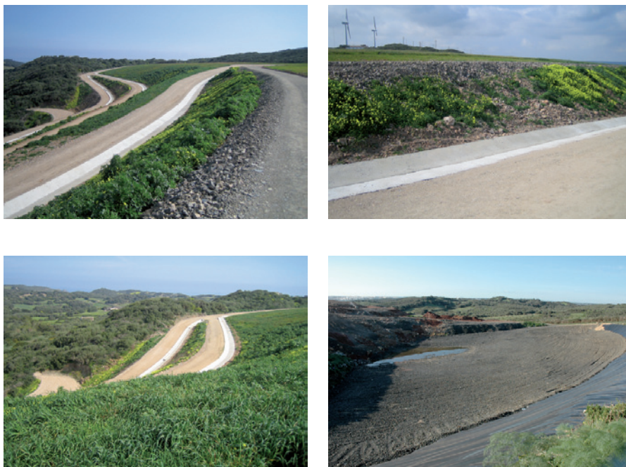
Figures 7 / 8 / 9 / 10. Camins d'accés / Vista del talús / Revegetació herbàcia / Vas condicionat (Fotos: Consorci de Residus Urbans i Energia de Menorca)
